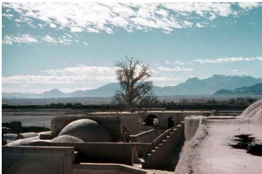
Fig. 3 – Yazd. Il clima, il paesaggio, i materiali costruttivi (Foto di Mehdi Kowsar).
