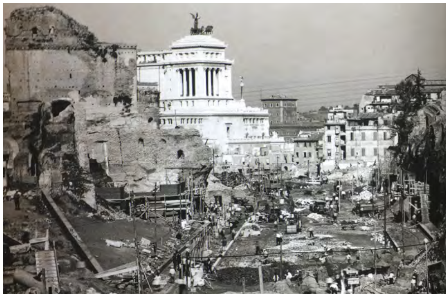
Fig. 8: Roma, Lo sventramento di Via dei Fori imperiali (dal 1931).
