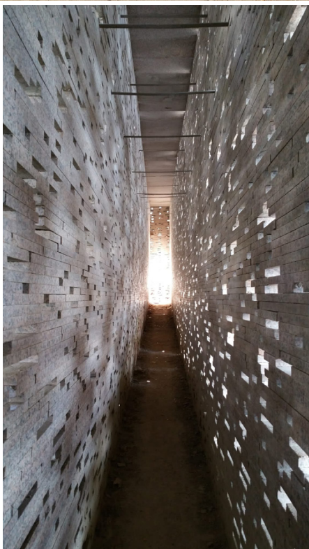
Fig. 1. Granada, Spagna, muraglia Nazarí nell'Alto Albaicín, accostamento del nuovo muro di granito Rosa Porriño con il vecchio muro di tapial, progetto arch. Antonio Jiménez Torrecillas, 2003-2006 (foto di Gómez Martínez, 2024).
