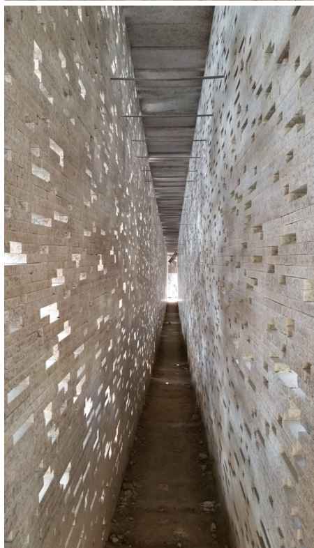
Fig. 1. Granada, Spagna, muraglia Nazarí nell'Alto Albaicín, accostamento del nuovo muro di granito Rosa Porriño con il vecchio muro di tapial, progetto arch. Antonio Jiménez Torrecillas, 2003-2006 (foto di Gómez Martínez, 2024).
